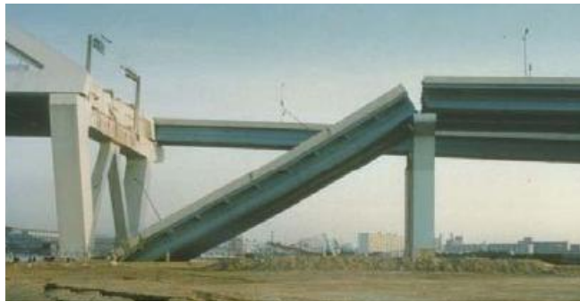
Slika 2. Oštećenja usled gubitka oslonca (Kobe, 1995), prema [7]
