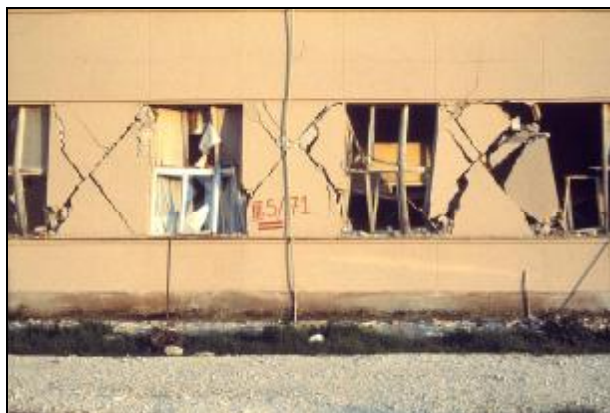
Slika 12. Budva, 1979: rušenje zidova od opeke na smicanje Figure 12. Budva, 1979: Brick wall failure due to shear
